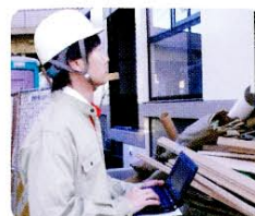
▲工事現場にて
